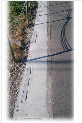
道路と側溝の段差を解消して通行しやすい生活道路にしました。
