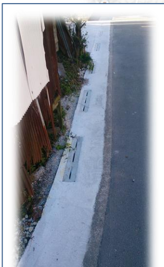
道路と側溝の段差を解消して通行しやすい生活道路にしました。
